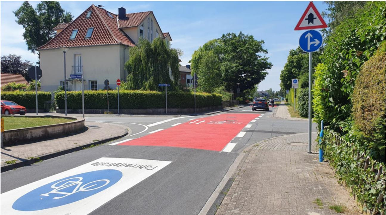
**Fahrradstraße in Celle:** An den Einmündungen weisen farbliche Markierungen sowie ein auf die Fahrbahn aufgebrachtes Verkehrszeichen „Fahrradstraße“ auf Radfahrende hin. Die Fahrradstraße ist vorfahrtsberechtigt, an den Einmündungen ist für den Querverkehr ein Stopp-Schild aufgestellt worden.
