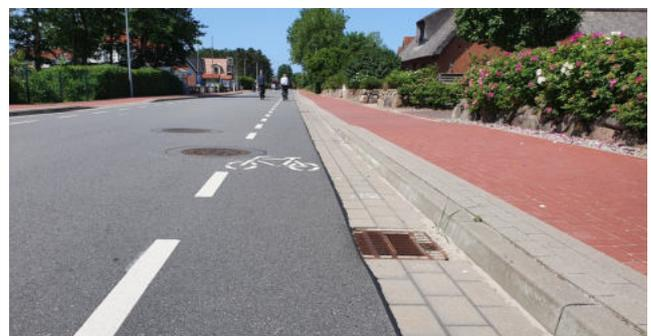
Fahrbahn hergestellt, so dass diese mit dem Fahrrad befahrbar ist und der effektive Querschnitt der Fahrbahn sich erhöht.
