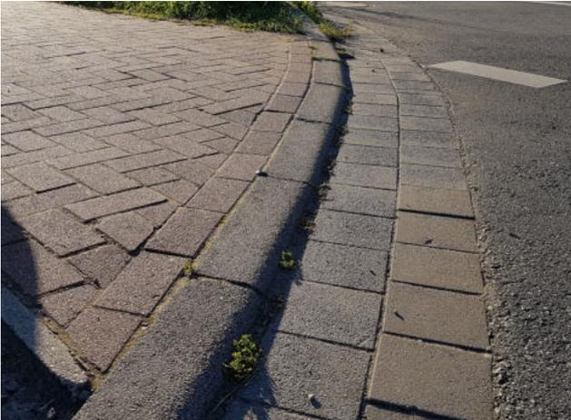
**Ahrenloher Straße auf Höhe Kuhlenweg**, an der Einmündung verläuft die Bordsteinkante quer zur Fahrtrichtung und ist mehrere Zentimeter hoch.
