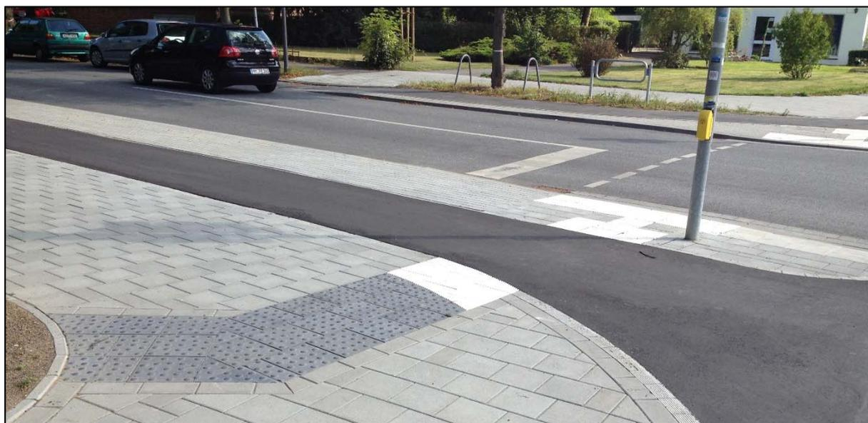
*Bild 4.22: barrierefreier Knotenpunktausbau*
