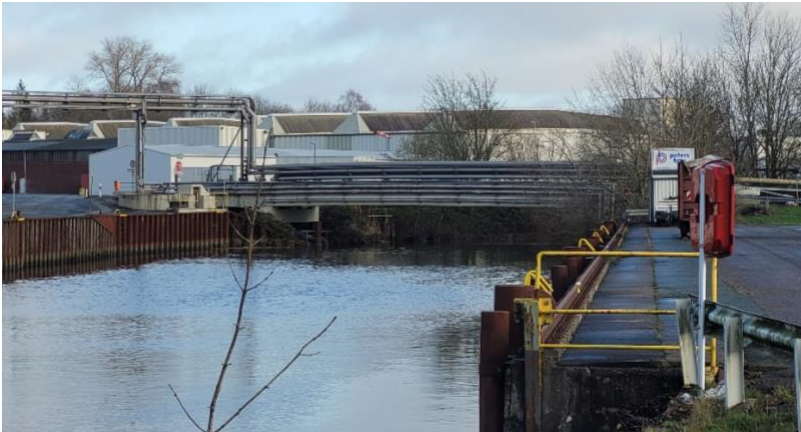
Brücke über die Pinnau auf dem Gelände der Feldmühle
