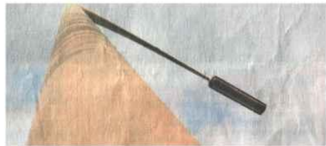
Die Tage der alten „Peitschenlampen“ sind gezählt. Sie fressen Energie, die Standfestigkeit ist durch Wind, Hunde-Urin und Streusalz grenzwertig.
