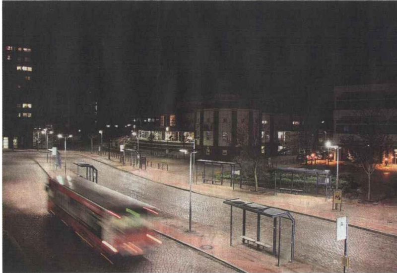
Helles Licht aus Energiespar-Leuchten: Wie hier am ZOB in Itzehoe haben einige Gemeinden bereits ihre Straßenbeleuchtung optimiert, andere sind kurz davor. Foto: Gottfried
