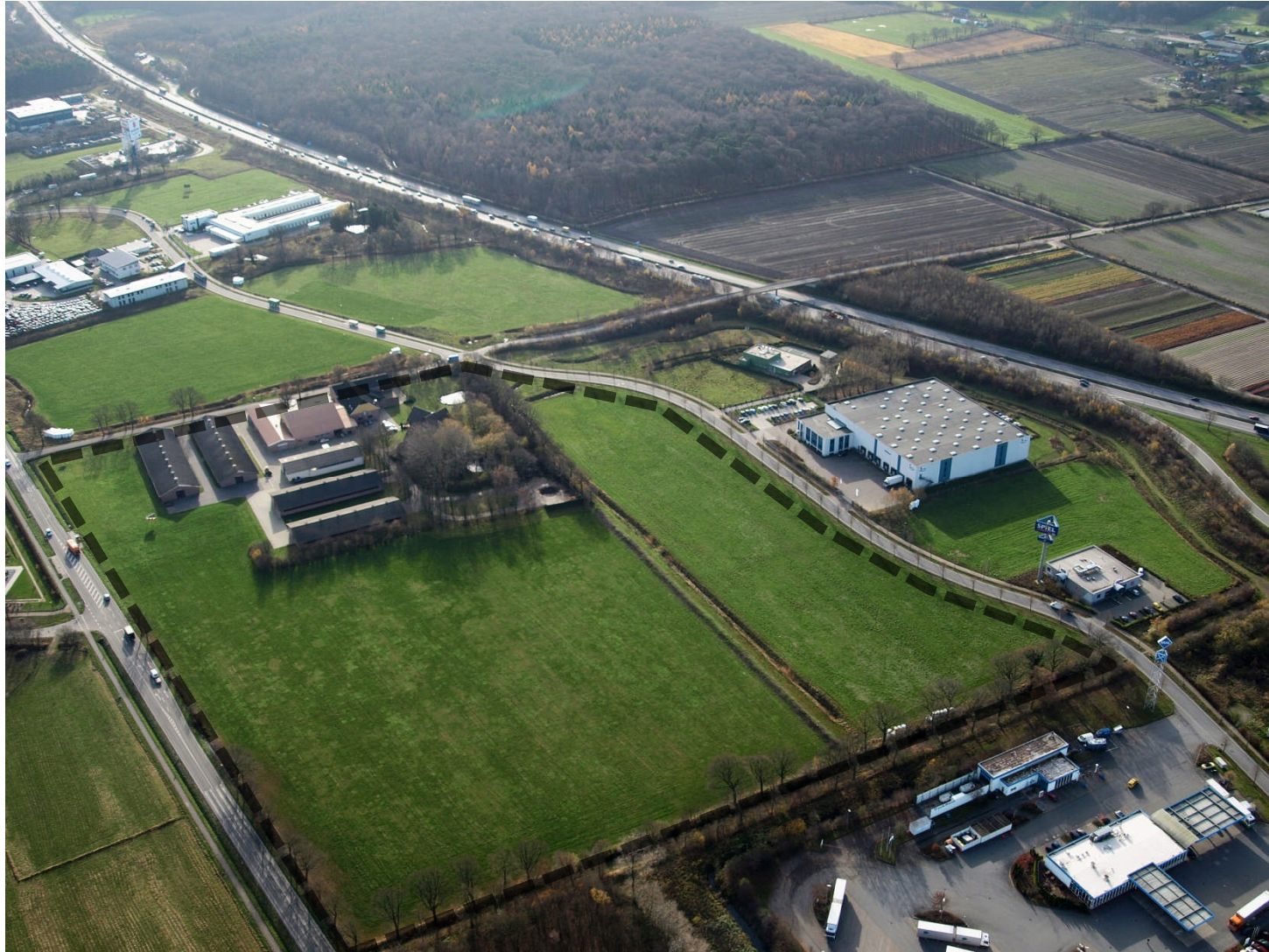
Schrägluftbildaufnahme (2009) – Blickrichtung Süden
