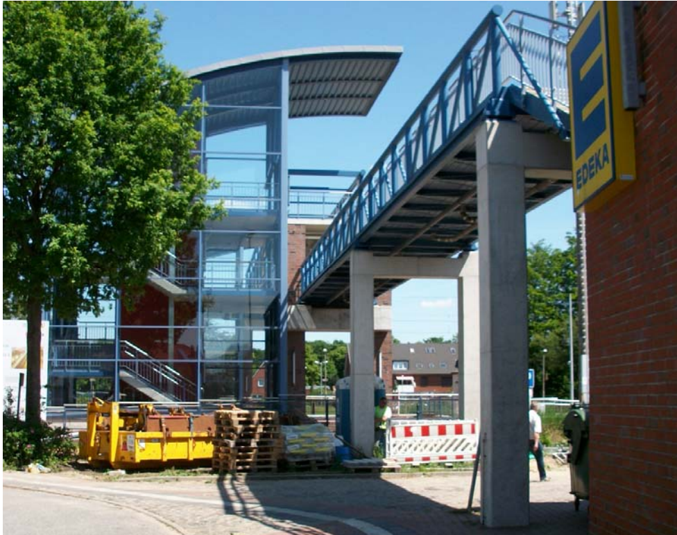
Bahnbrücke (Radfahrer- und Fußgängerüberführung)
