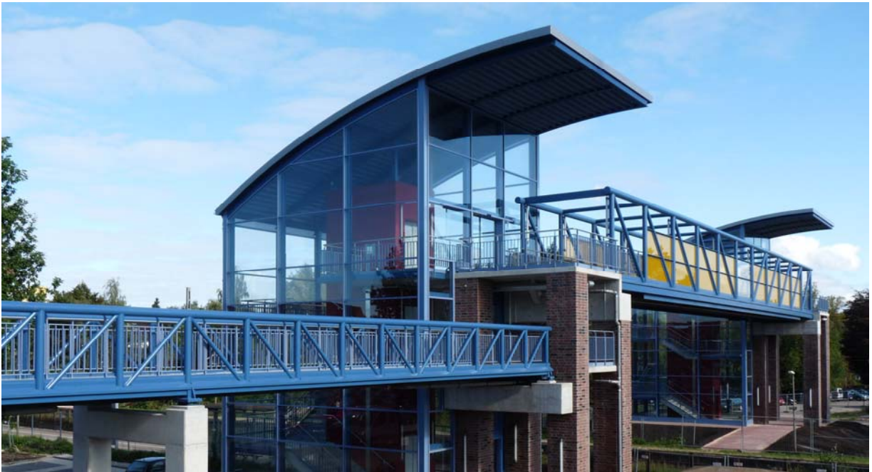
Bau einer Radfahrer- und Fußgängerüberführung
