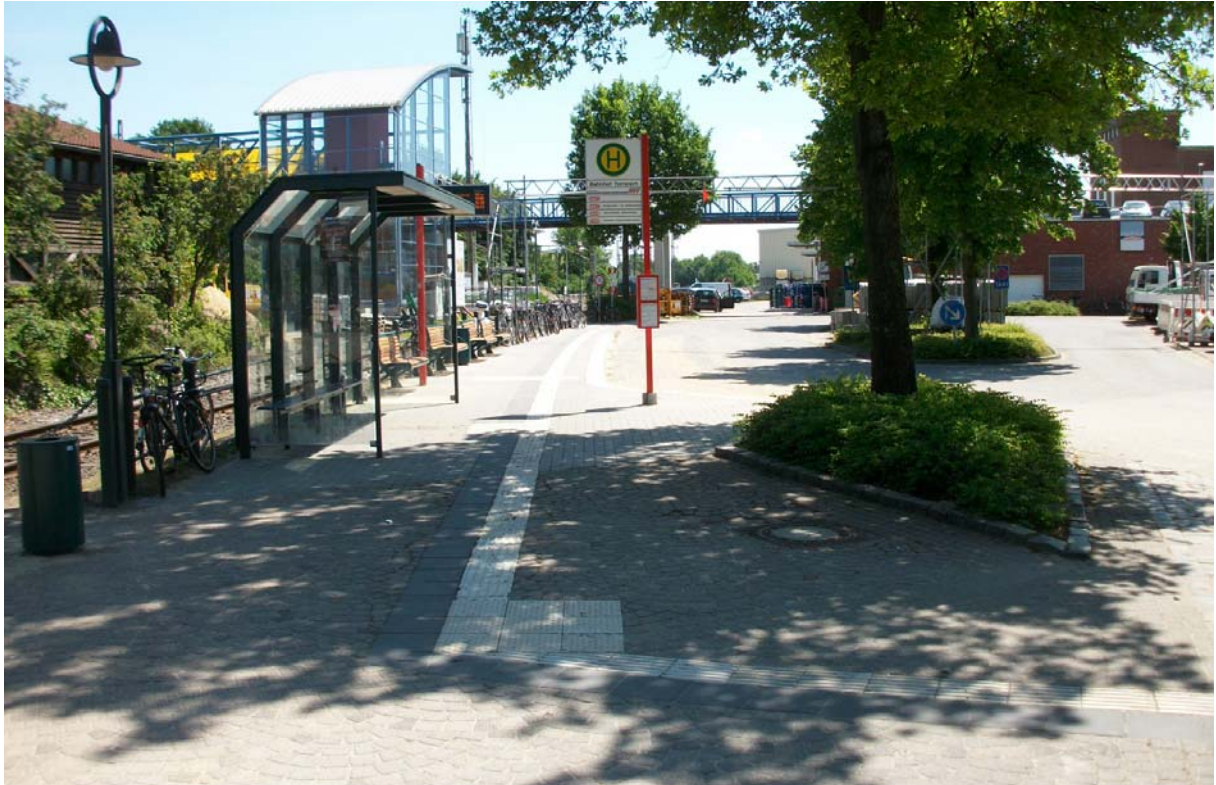
Bushaltestelle mit taktilen Leitelementen (2013)
