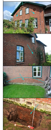
Bild 1 Südost - Fassade Vorhandene Risse an den Gebäudeecken im Verlauf vom Traufpunkt / Auflagerbereich der Fußfette unter 45° zum Fenstersturz. Die Risse wurden mehrfach saniert. Die Verbundebene ist aber gelöst. Schwaches Adhäsionsversagen. Mögliche Ursache sind Zwängungsspannungen im Systemaufbau.
