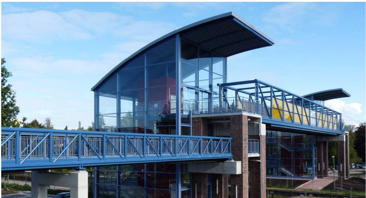
Bau einer Radfahrer- und Fußgängerüberführung
