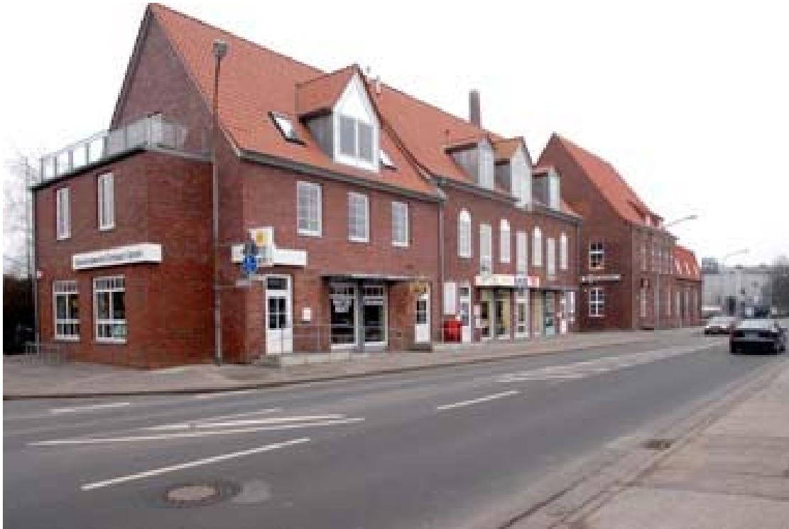
Sanierte Gebäude der ehemaligen Brennerei mit Büro-, Laden- und gastronomischer Nutzung
