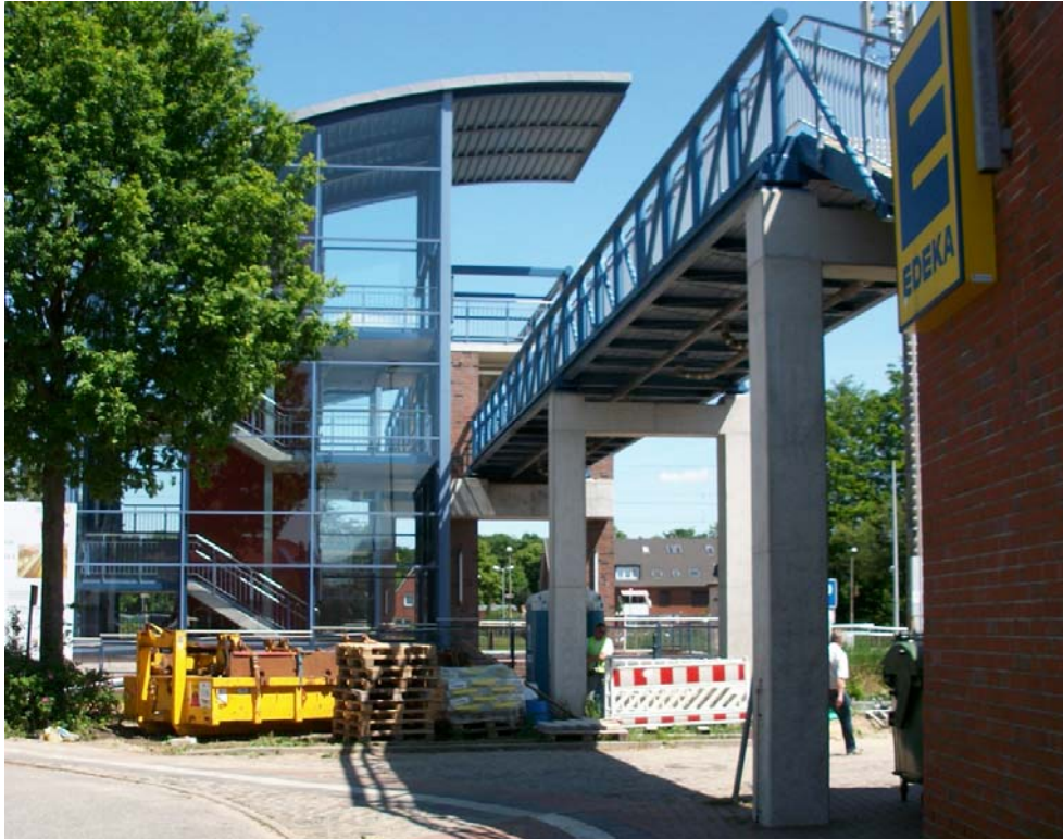
Bahnbrücke (Radfahrer- und Fußgängerüberführung)
