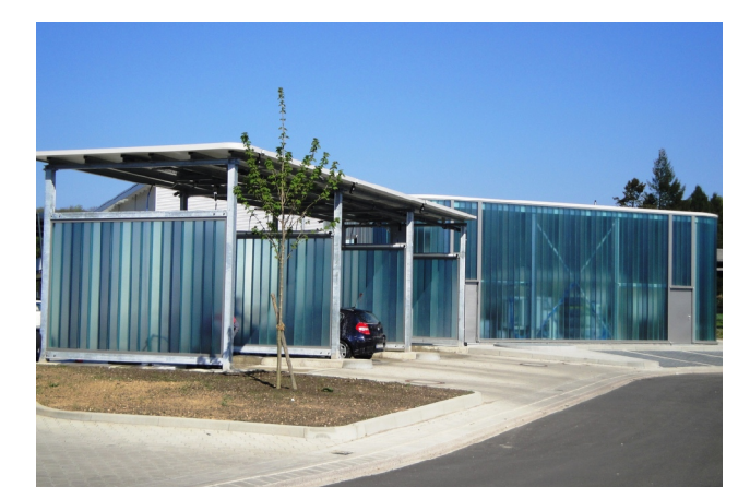
Pilkington Profilit als Vorhangfassade und Raumtrenner
