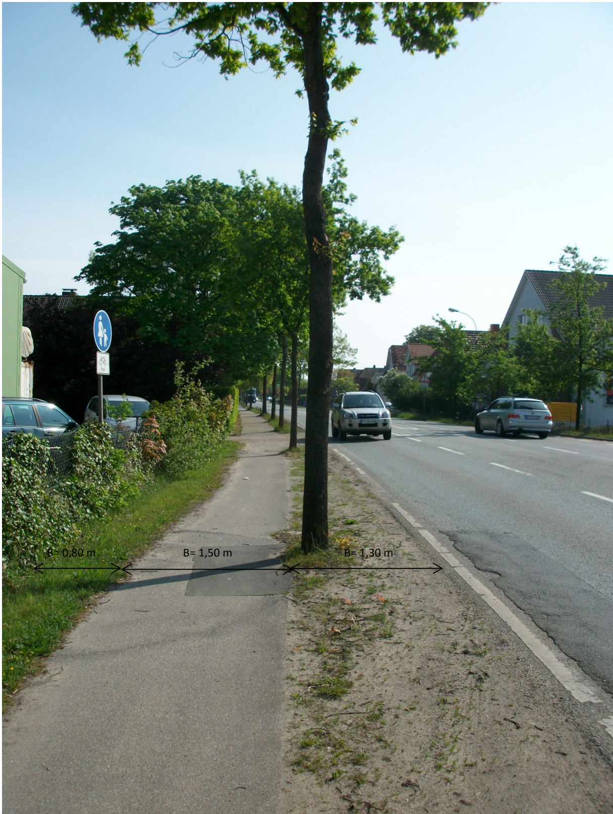
Ahrenloher Straße 87 – Blickrichtung Kreisverkehr
