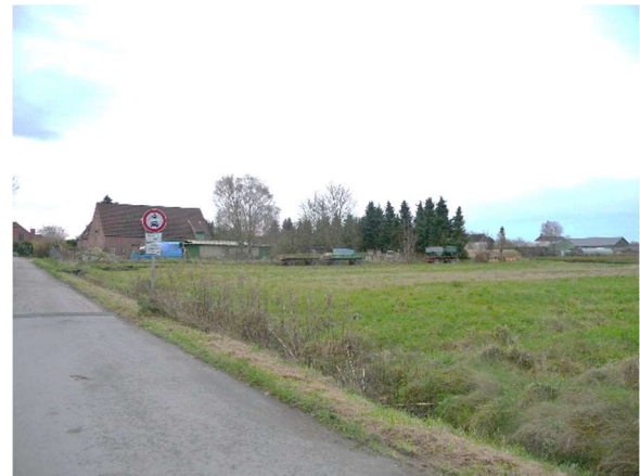
Abb.: Blick von der Einmündung „Moorkamp“ nach Südwesten auf die Rückseite der Bestandsbebauung im Plangebiet
