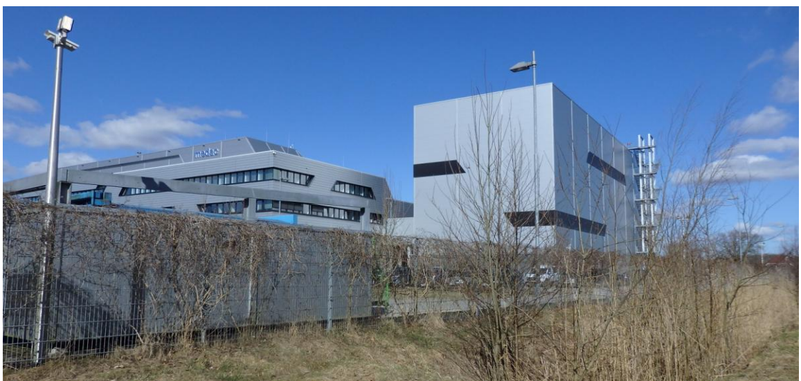
Blick von Süden , mit dem Ohlenkamp im Rücken. Rechts im Bild das hohe Lagergebäude (03 / 2018)
