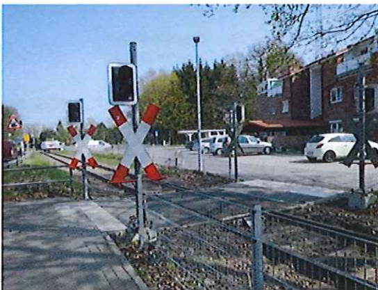
Abbildung 5: Tornescher Weg (Uetersen): Verbreiterung eines Bahnüberganges
