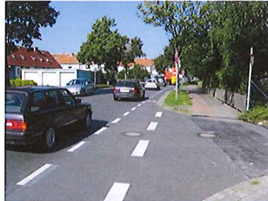
Abbildung 10: Beispiel eines einseitigen Schutzstreifens (Hameln)
