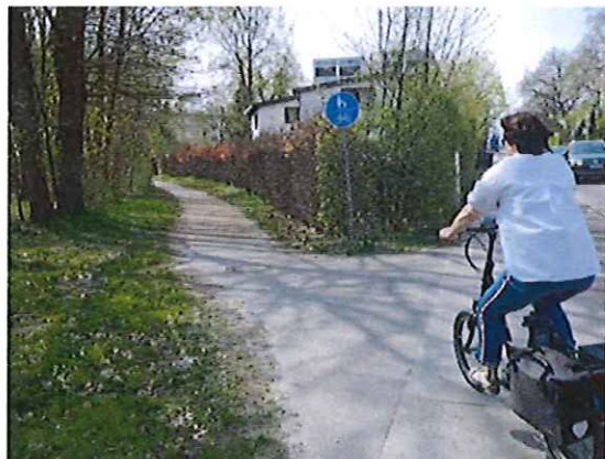
Abbildung 6: Verbindung Tornescher Weg – Hebbelstraße (Uetersen): Befestigter Ausbau (Asphalt) mit Bau Entwässerung, Beleuchtung (LED, Energieautark, Bewegungssteuerung)
