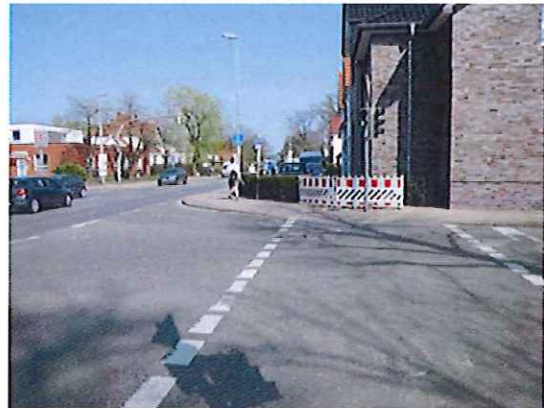
Abbildung 4: Arenhorner Straße (Tornesch): Beschleunigung des Radverkehrs durch verbesserte Signalisierung und Radverkehrsfurten
