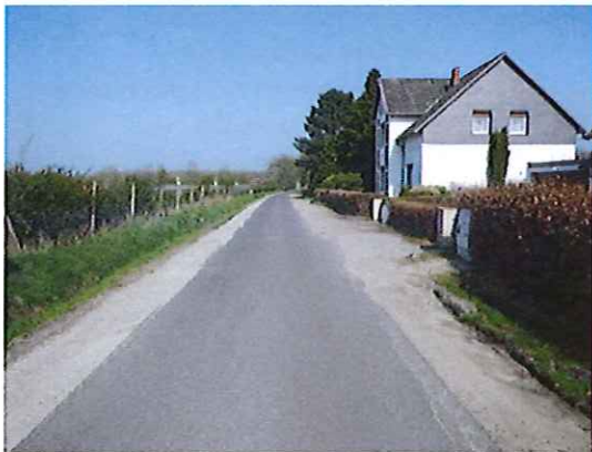
Abbildung 3: Asperhorner Weg (Tornesch): Beleuchtung mit energieautarken und bedarfsgesteuerten LED-Leuchten,
