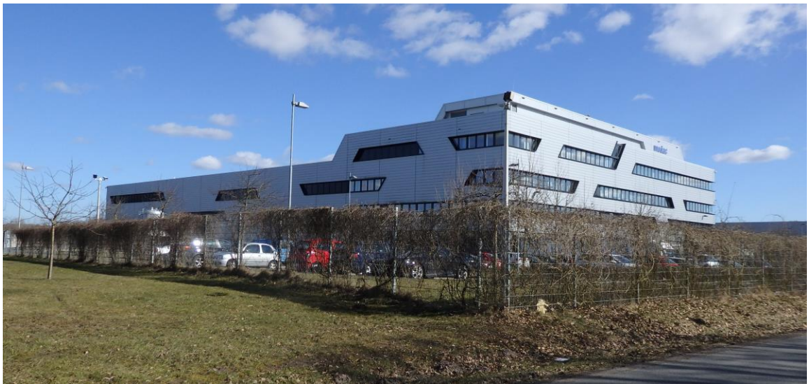
Blick von Westen , mit dem Ohlenkamp im Rücken, direkt an der Zufahrt zum Gelände (03 / 2018)
