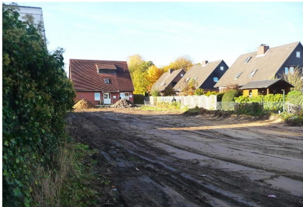
Abbildung 10 - Blick von der Esinger Straße über das Fl.st. 310/89 – hier wurde die vorherige Bebauung bereits abgerissen. Im Hintergrund von links nach rechts die Bebauungen Esinger Straße Nr. 12a und die Bebauungen am Levy-Schäfer-Weg
