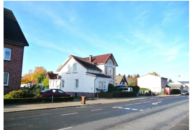
Abbildung 9 - Blick über die Esinger Straße auf das Gebäude Esinger Str. Nr. 14 (Fl.st. 320/89)
