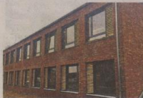
An der Eckerkoppel in Farmsen steht das erste „Klassenhaus“. FOTO: SBH
