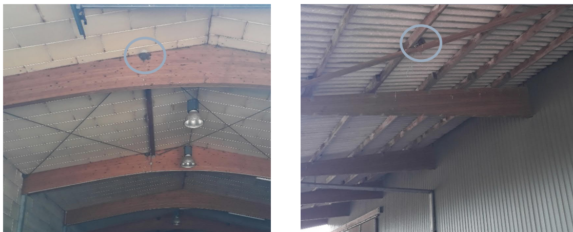
Abb: Nester im/am Bestandsgebäude (links: Rauchschwalbe, rechts indet. ; Mai 2019)
