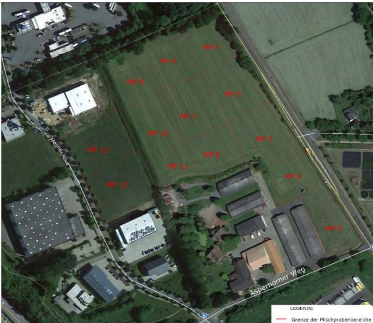
Abb. 10 - Lage der Mischprobenbereiche (Untersuchung von Oberbodenmischproben, Dipl. - Geol. H. Ziegenmeyer Umweltgeotechnik, Elmshorn, Oktober 2015)
